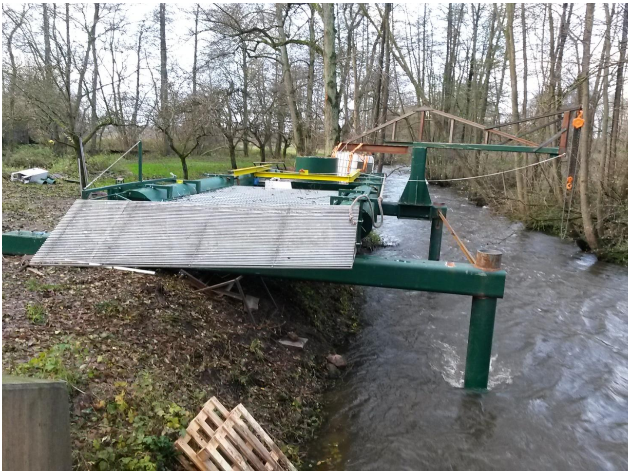
Abbildung 2: Energierotor, Stand der Arbeiten am 18.11.2015.
